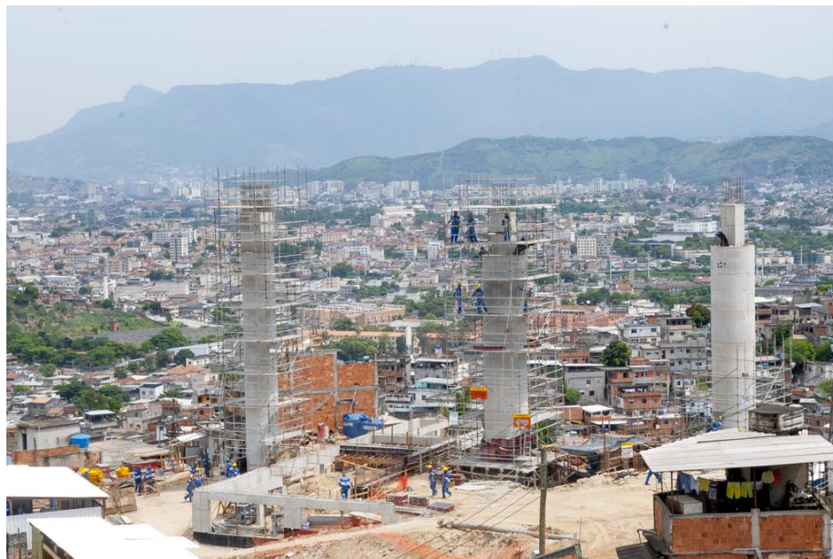
FIGURA 4 - Construção do Teleférico no Conjunto de Favelas do Complexo do Alemão
