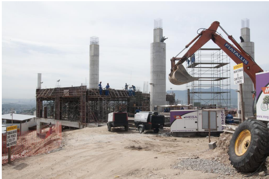
FIGURA 5 - Construção do Teleférico no Conjunto de Favelas do Complexo do Alemão
