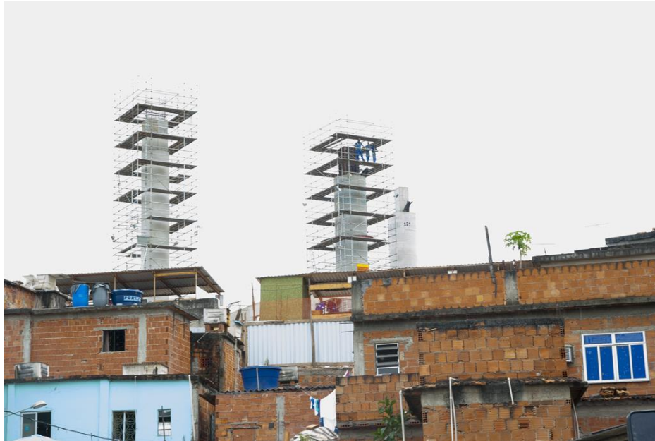
FIGURA 3 – Construção do Teleférico no Conjunto de Favelas do Complexo do Alemão
