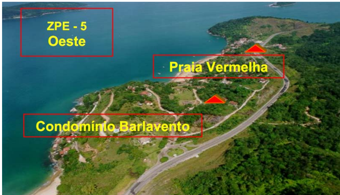
Figura 13: Posicionamento das Sirenes no Lado Oeste da CNAAA, na ZPE 5
