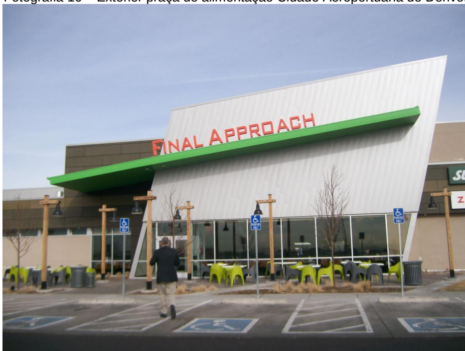
Fotografia 16 – Exterior praça de alimentação Cidade Aeroportuária de Denver
