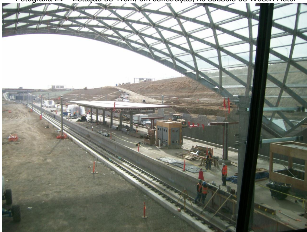
Fotografia 21 – Estação de Trem, em construção, no subsolo do Westin Hotel
