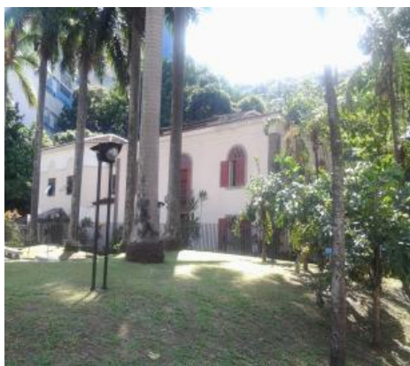
Figura 1: Visão externa do prédio da biblioteca de Botafogo.
