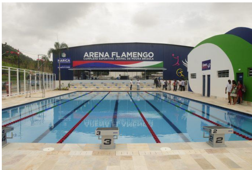
FIGURA 7 – Arena Flamengo em Maricá, RJ
